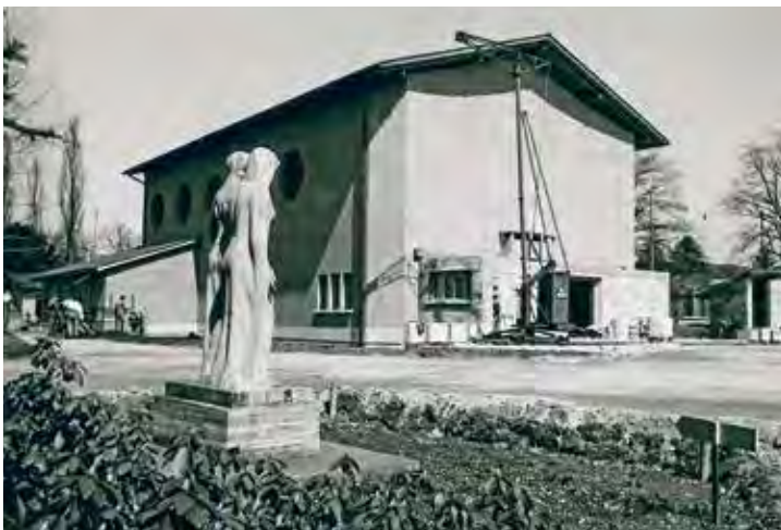
Bau der Abdankungshalle, um 1953/54
